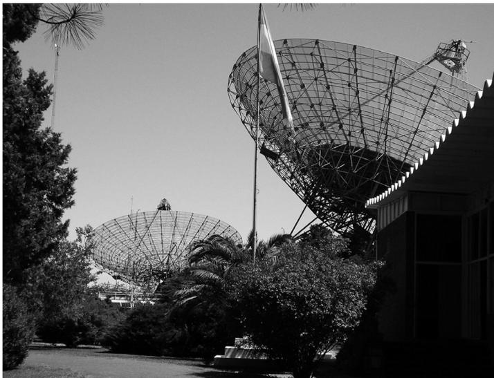
**Fig. 4.** El Instituto Argentino de Radioastronomía (IAR) dependiente del Conicet, dispone de dos antenas de 30 m y puede operar en diversas frecuencias entre 1,4 y 5 GHz. La antena 2 fue utilizada regularmente para hacer el relevamiento de todo el cielo del hemisferio sur, buscado señales de origen artificial con una resolución espectral de 0,05 Hz y una sensibilidad de  $10^{-24}$  Wm<sup>-2</sup>. Foto: G.A. Lemarchand.
