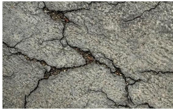
图 1.4 结构性破损
