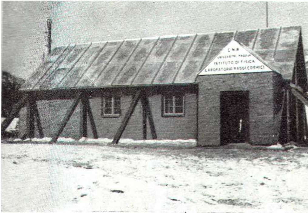
Fig. 3. – Veduta di fronte del laboratorio.
